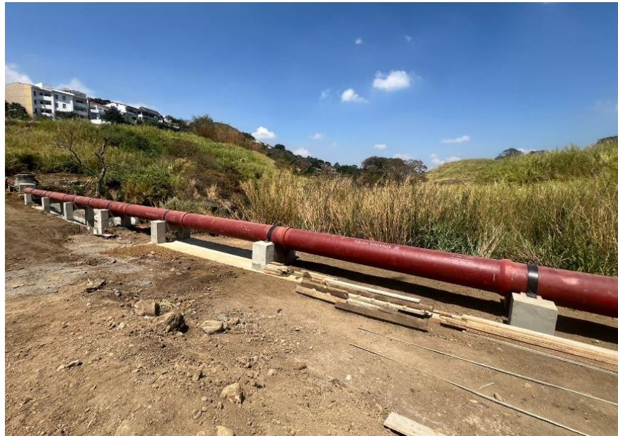
Imagen #32. Tubería para atención de colapso entre los pozos 9-93 y 9-94.
