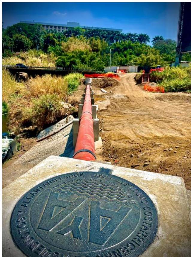
Imagen #33. Tubería para atención de colapso entre los pozos 9-93 y 9-94.
