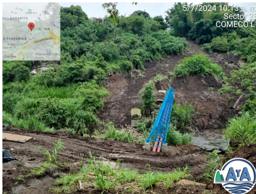
Imagen #30. Estructura metálica y tuberías nuevas, colapso atendido entre pozos 7-24 y 1-38
