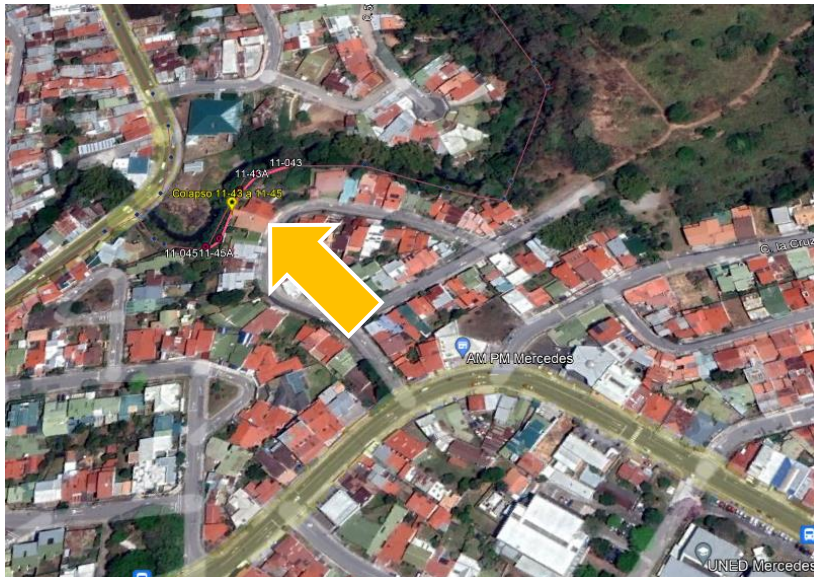
Imagen #21. Colapso entre pozo 11-43 al 11-45
