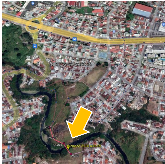
Imagen #25 Colapso entre pozo 25-68 a 25-69
