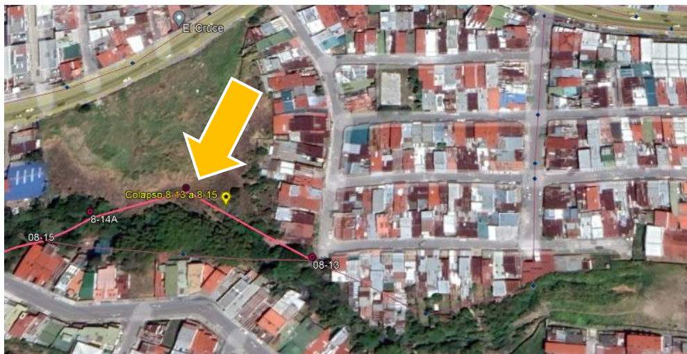
Imagen #15. Colapso entre pozos 8-13 y 8-15
