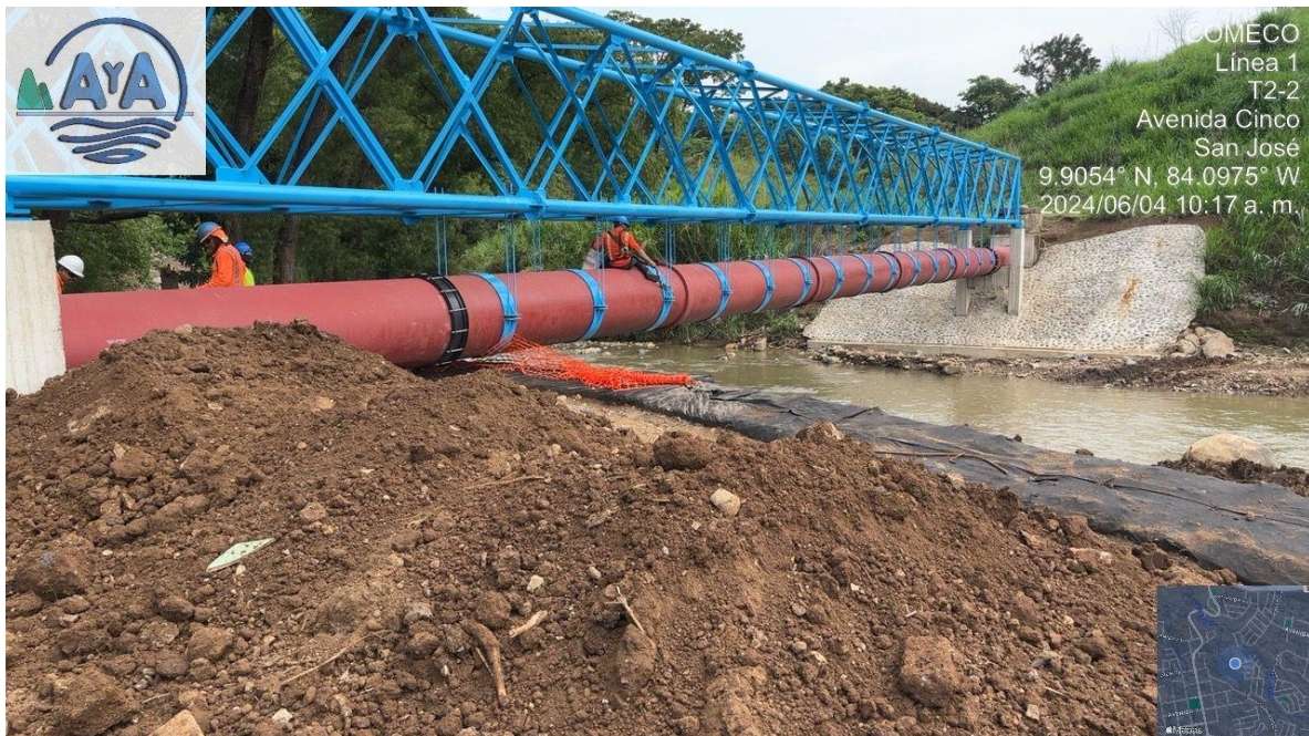
Imagen #26 Puente para atención de colapso entre pozo 25-68 a 25-69
