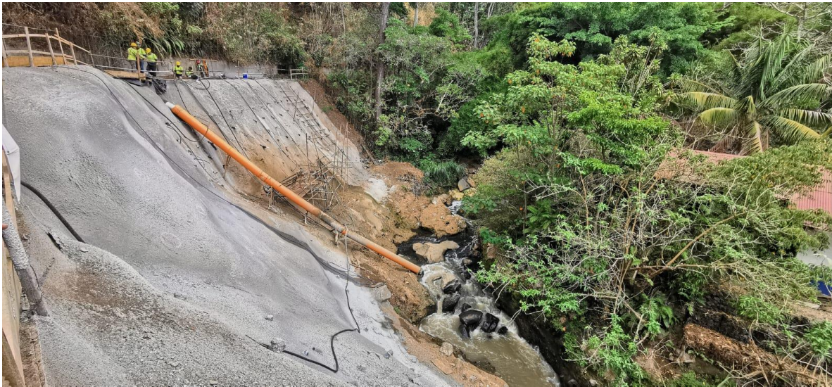
Imagen #20. Construcción de pantalla anclada para atención de colapso entre pozo 10-22 al 10-25
