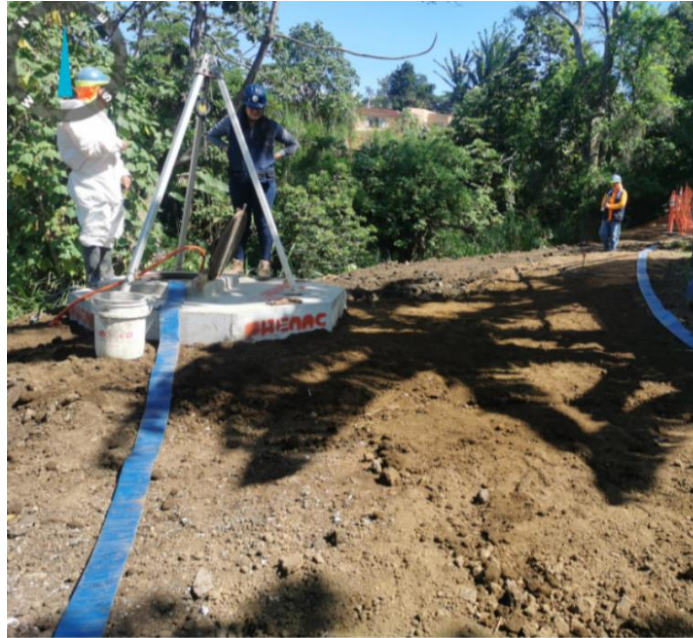
Imagen #22. Acabados en pozos, colapso atendido entre pozo 11-43 al 11-5
