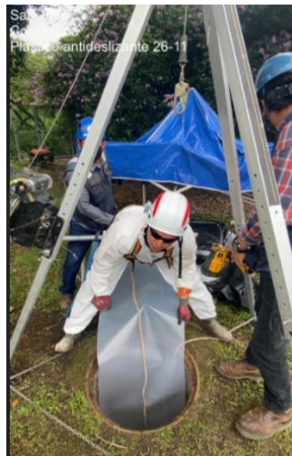
Imagen #28 Rehabilitación por CIPP de tubería, colapso atendido entre los pozos 26-10 y 26-12
